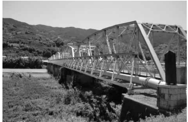
三谷井土地改良区通水橋
