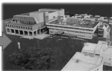
津波浸水時の田辺市役所
