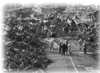
道路啓開の様子
