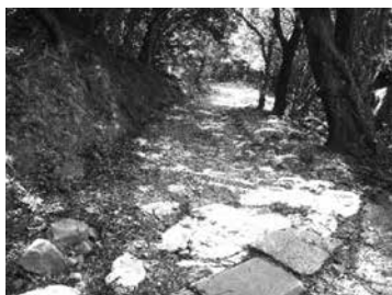
友ヶ島：歩道の補修箇所(図表10)
